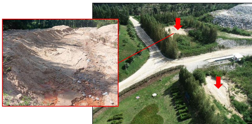
รูปที่ 2.8 บ่อดักตะกอน ขนาดพื้นที่ 1.35 ไร่ ลึก 3 เมตร และ บ่อดักตะกอน ขนาดพื้นที่ 1.5 ไร่ ลึก 3 เมตร
