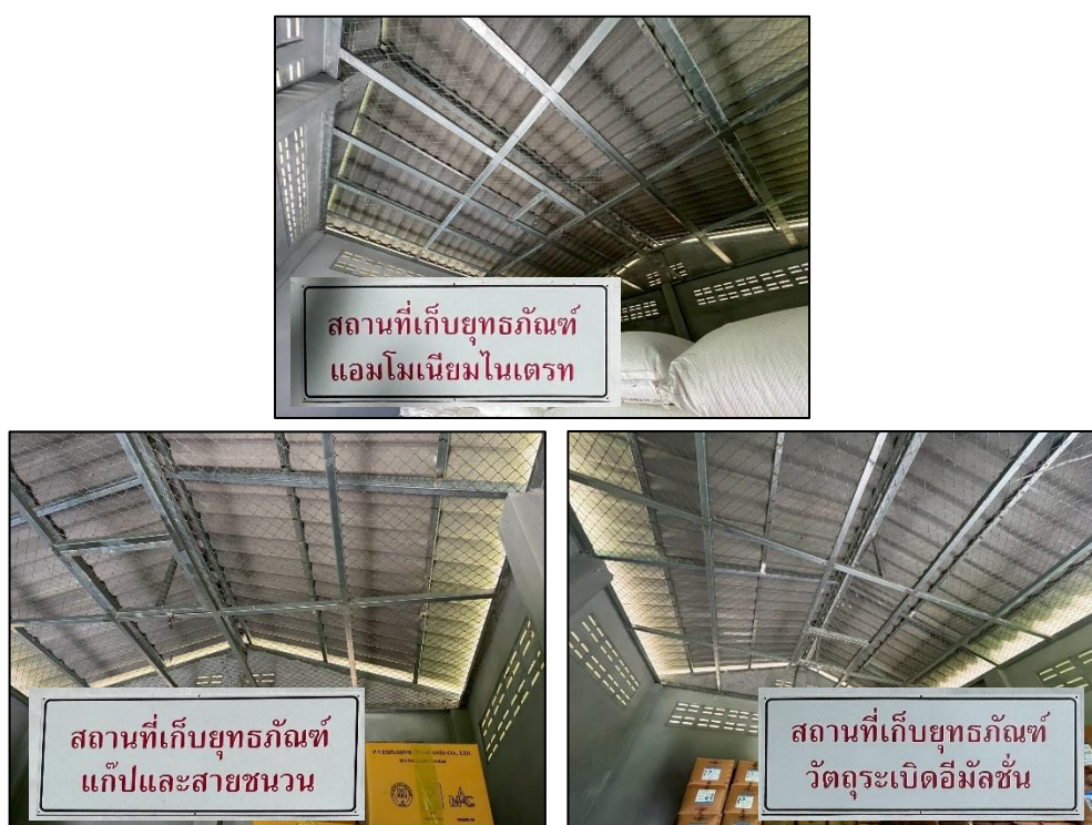
รูปที่ 2.54 คลังเก็บวัตถุระเบิดทุกคลังมีการระบายอากาศเป็นอย่างดี
